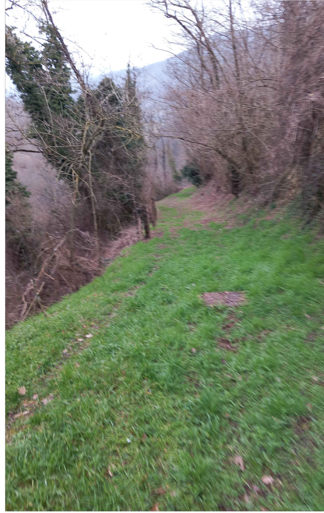
FOTO STATO DI FATTO
