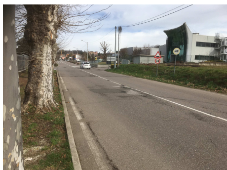
Via Cavour verso nord secondo tratto
